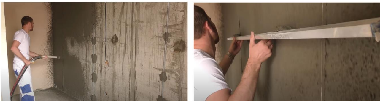
Рис. 16. Схема нанесения обрызга на поверхность и разравнивание правилами образовавшихся наплывов
